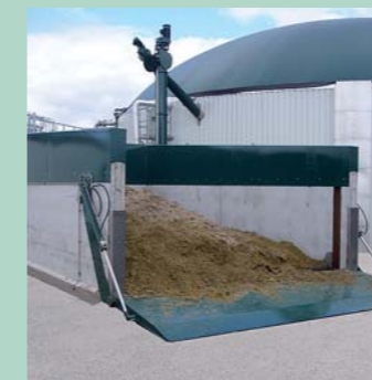
Dosificadores de sólidos transitables en construcción de hormigón Serie de construcción ZBC con rampa de cierre hidráulica
